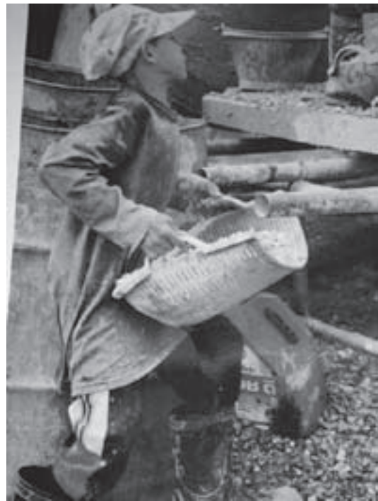
ภาพที่ 4 เด็กทำงานก่อสร้าง
